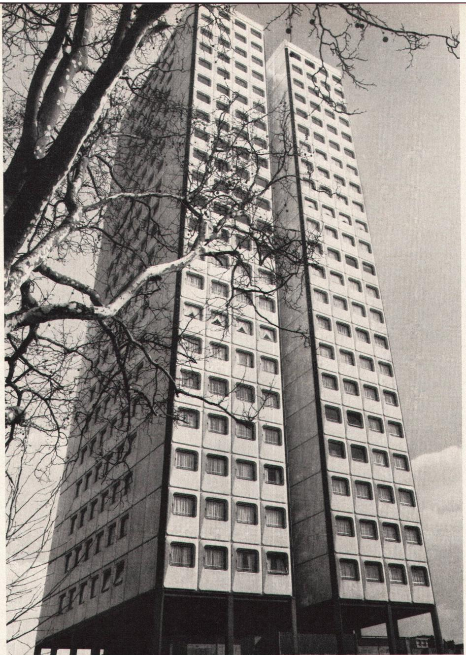
kleidung eines tragenden Stahlgerüsts mit vorfabrizierten Fassadenelementen aus fiberglasverstärktem Polyester zur Anwendung.
