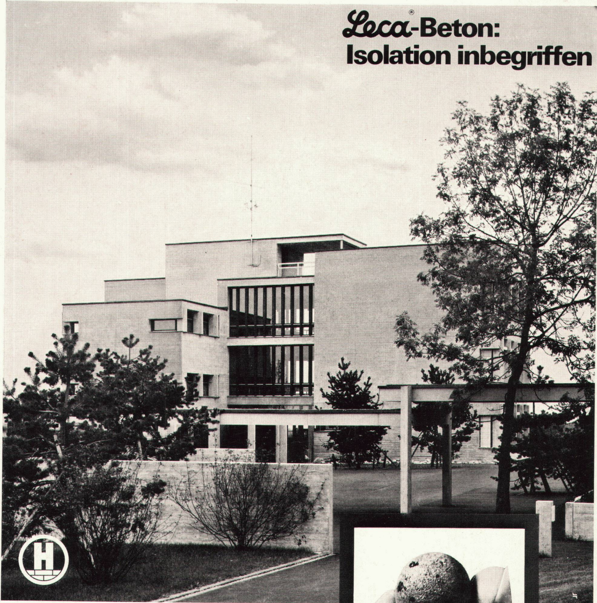
Schulhaus in Pfaffhausen aus Leca-Schüttbeton mit Sichtstruktur Planung: Bridel + Spirig, Architekten, Zürich Statik: Jacobson + Včkovski, Ingenieure, Zürich Bauausführung: H. Ochsner + Co, Bauunternehmung, Zürich
