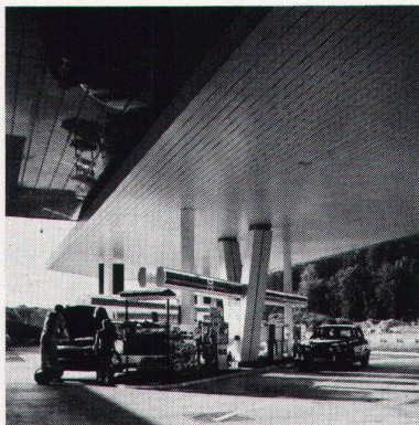
Autobahnrestaurant Würenlos LUXALON®-Fassadenverkleidung Typ 150 F (als Decke montiert)
