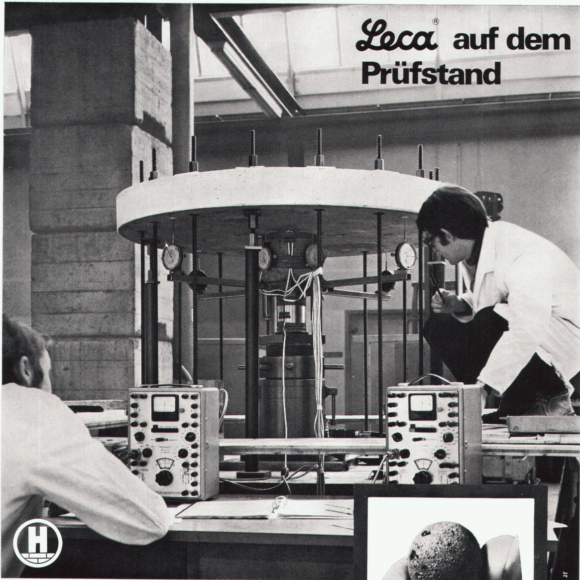
Durchstanz-Versuch an Leca h 3d - Beton in der Eidgenössischen Materialprüfungs-Anstalt (EMPA), Dübendorf
