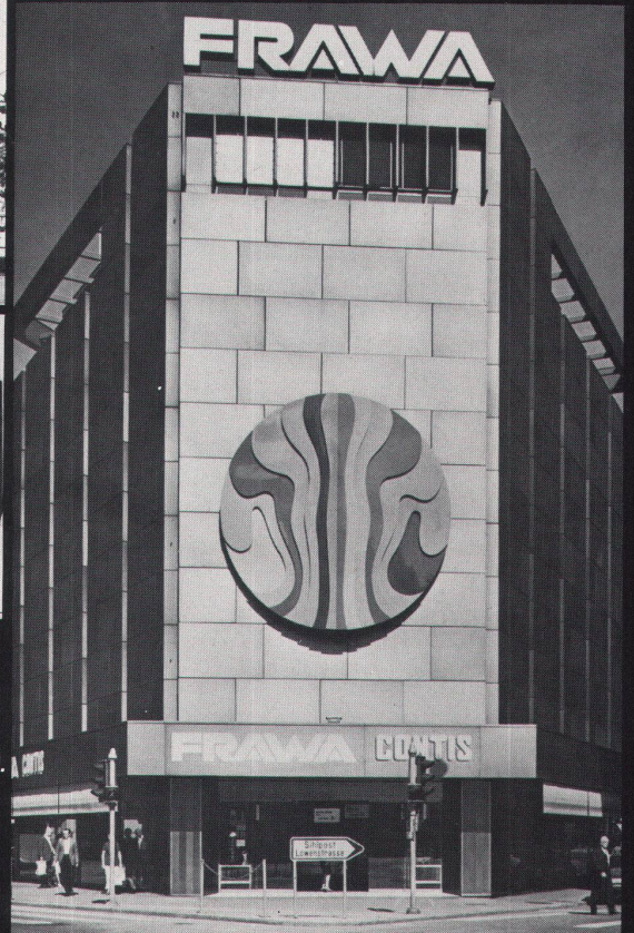
Geschäftshaus Frawa AG, Zürich. Aluminium-Fassaden-Verkleidung mit Fenstern Modell HZ 750.
