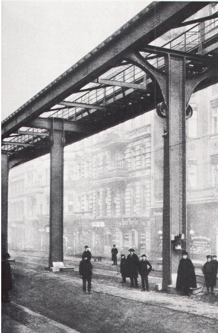
1 Arrêt-type du chemin de fer aérien de Berlin, création Alfred Grenander. 2 Chemin pour piétons sous les viaducs en fer du chemin de fer aérien de Berlin. A observer les plantes entre les arbres bordant les allées, plantes qui font pendant aux arches en fer. Création Alfred Grenander.
