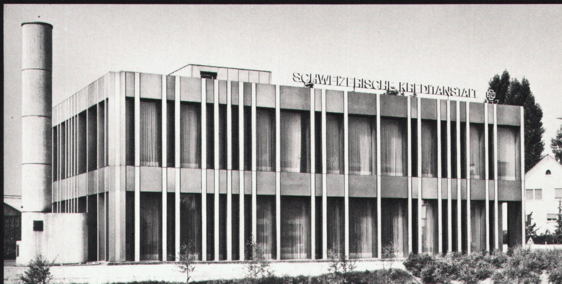
Bankgebäude der Schweizerischen Kreditanstalt in Schwerzenbach/ZH. Aluminium-Fassade mit vollisolierten Fenstern, Modell Alsec-50.
