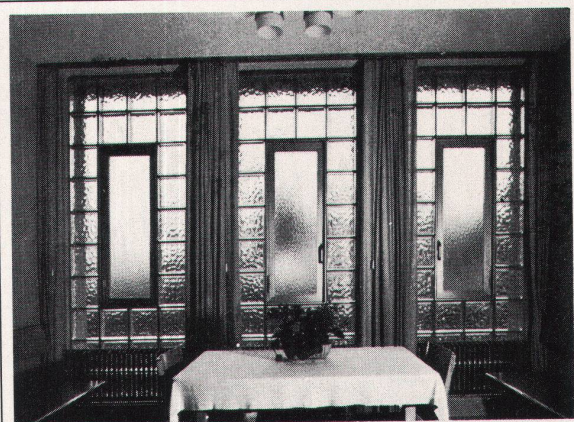
Glasbausteinfenster mit Anticorodal-Drehflügel in Sitzungszimmer.
