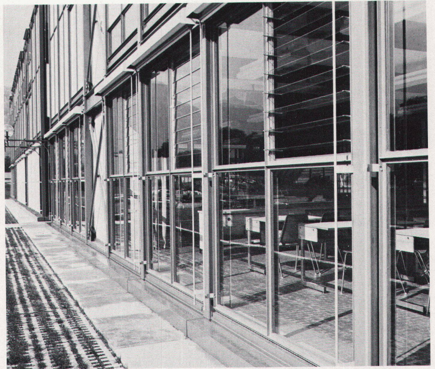
Détail de la façade
