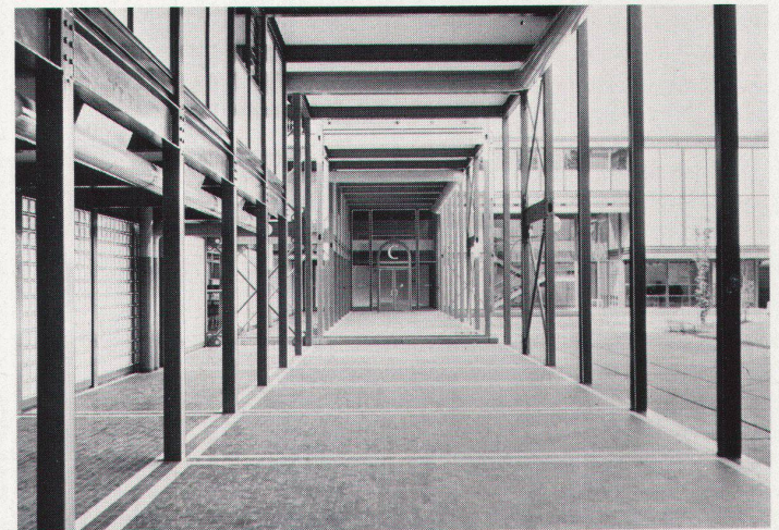
Le portique qui relie les bâtiments B et C
