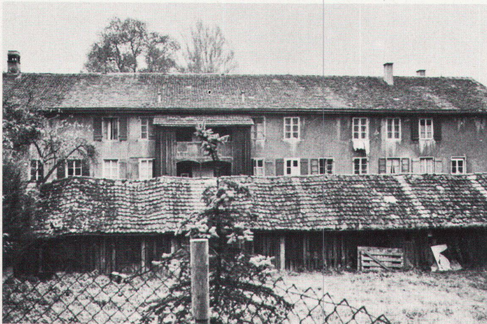
Die Rückfassade mit den Laubenanbauten
