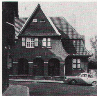
3 Beispiel eines Doppelhauses
