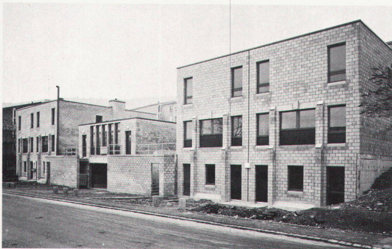
Gesamtansicht von der Fachstrasse her
