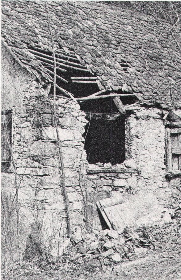
Ein Extremfall... aber er zeigt deutlich die Folgen eines undichten Daches. Dachstuhl, Fassade und Innenräume werden durch ungehemmtes Einwirken der Witterung stark in Mitleidenschaft gezogen. Diese alte Mühle wurde Ende der fünfziger Jahre restauriert. Seither dient sie als Jugendherberge.
