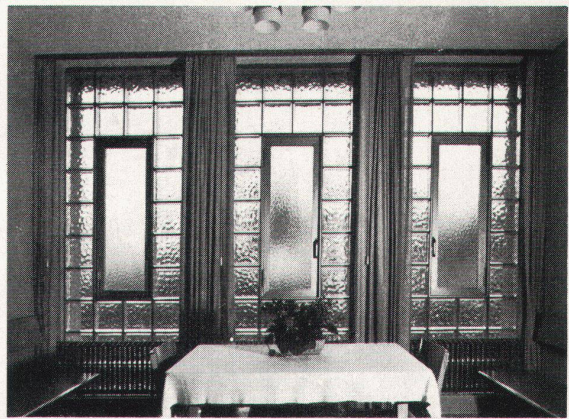
Glasbausteinfenster mit Anticorodal-Drehflügel in Sitzungszimmer.
