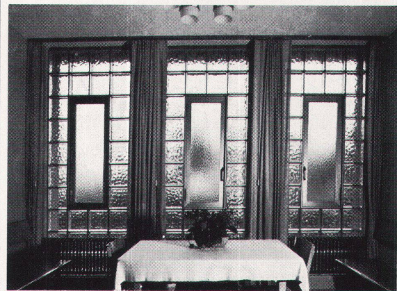
Glasbausteinfenster mit Anticorodal- Drehflügel in Sitzungszimmer.
