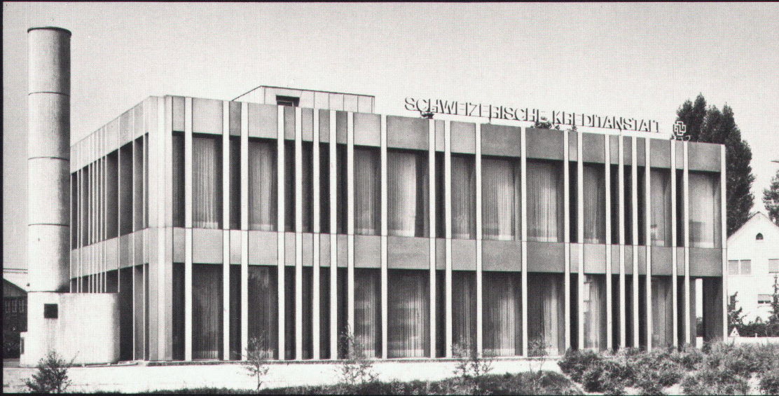
Bankgebäude der Schweizerischen Kreditanstalt in Schwerzenbach/ZH. Aluminium-Fassade mit vollisolierten Fenstern, Modell Alsecc-50.
