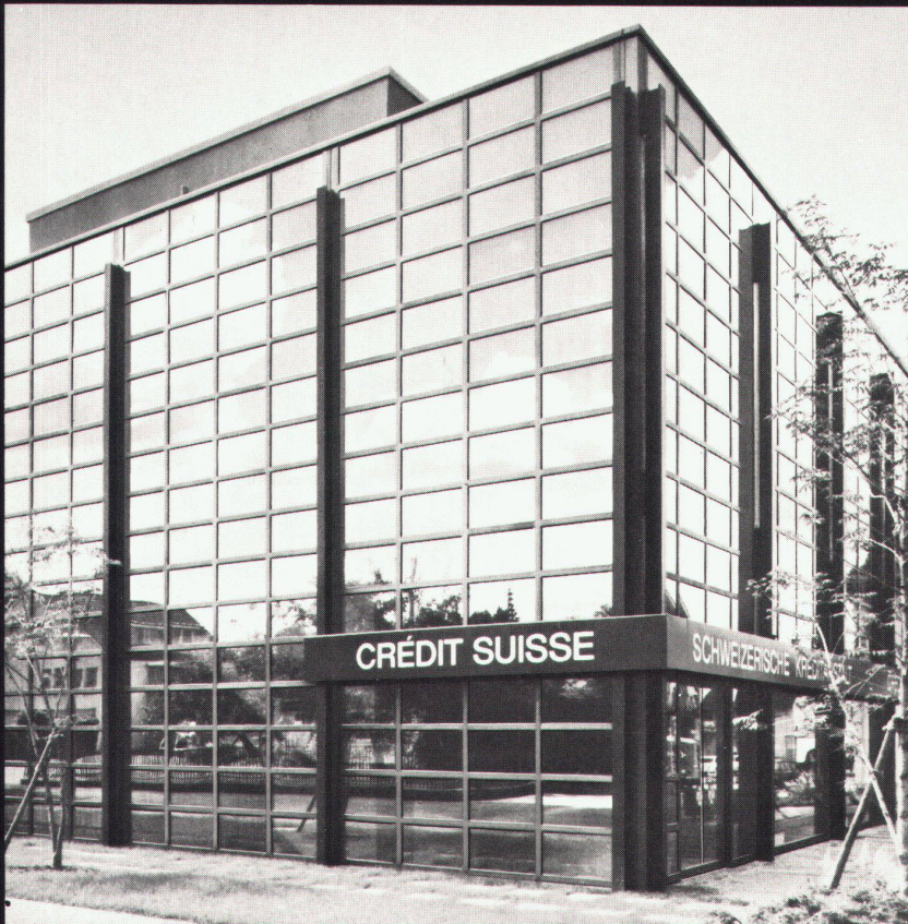
Bankgebäude der Schweizerischen Kreditanstalt in Wetzikon/ZH. Aluminium-Fassade mit vollisolierten Fenstern, Modell Alsecc-50.
