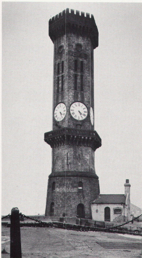
6 Historistischer Leuchtturm im Hafen von Liverpool, 1848 von Jesse Hartley erbaut. Foto: G. Germann 6 Phare historique du port de Liverpool, 1848, de Jesse Hartley. Photo: G. Germann
