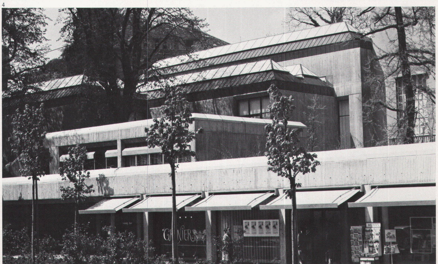
2 Der Erweiterungsbau vom Hirschengraben aus. Im Vordergrund die überdeckte Einfahrt zur Spedition, darüber Restaurierungsateliers
