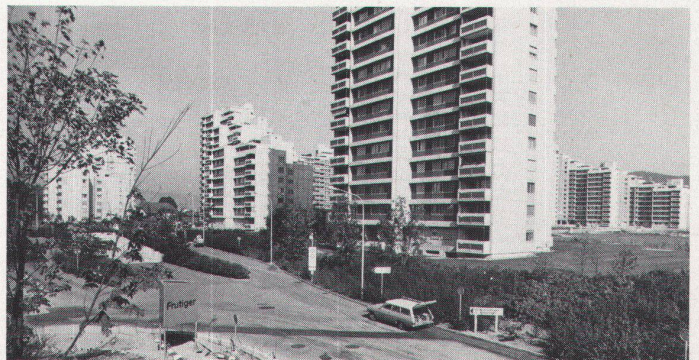
Westliche Zufahrt mit Rampe zur Verkehrsebene im Untergrund. Durchblick gegen das Schloss und den Ostermundigenberg
