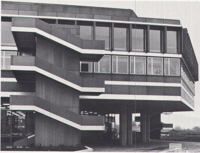
Grosses Hörsaalgebäude, Leichtmetallfassade und Fluchttreppe
