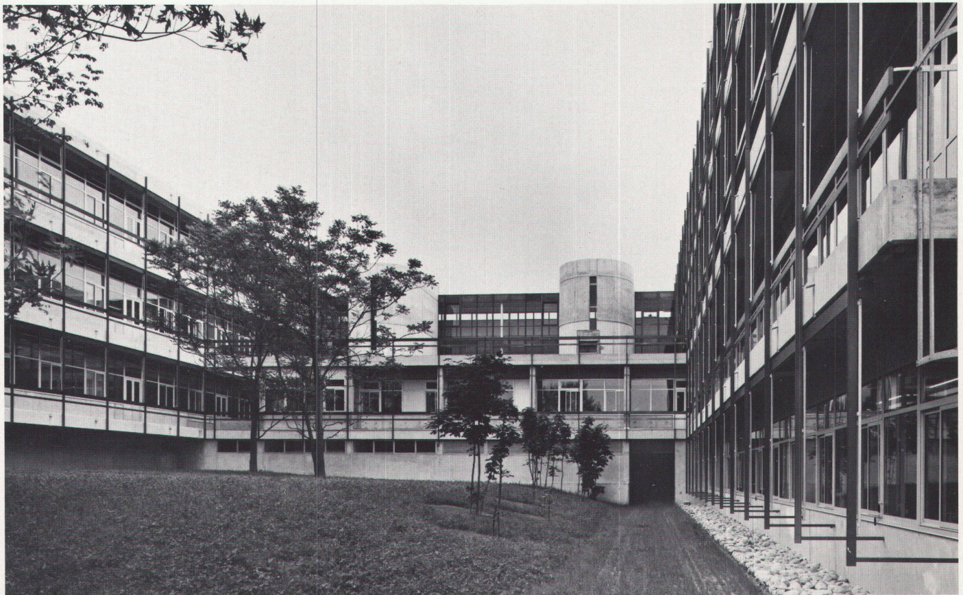
7 Collège propédeutique, vue de la cour nord avec les bâtiments laboratoires
