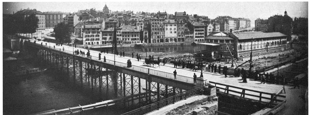
61 Quartier de Seujet vor den Abbrucharbeiten, 1890 ...
