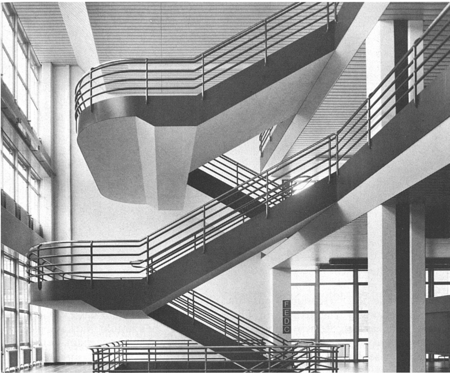
17 Freitragende Podesttreppen im Gemeinschaftstrakt
