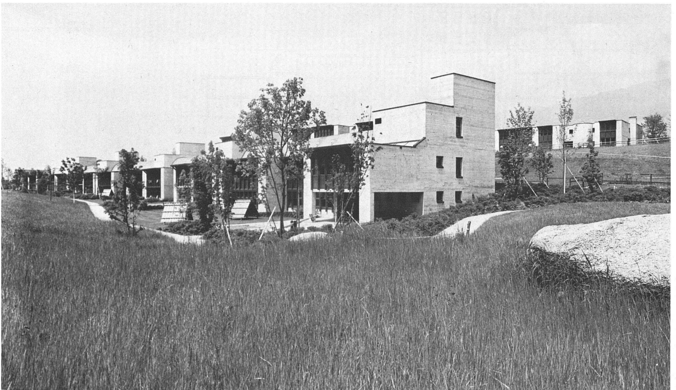
8 Gesamtansicht von Südosten / vue générale
