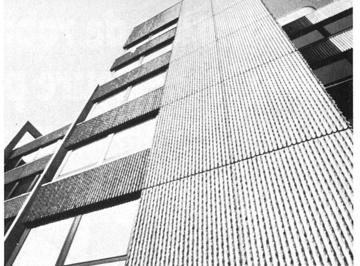
DURISOL-Fassadenelemente sind dreischichtig. Ein hochisolierender Kern wird beidseitig von einer Feinbetonschicht umschlossen. Durch ein besonderes Härungsverfahren erhält die Aussenschicht ihre Wetterbeständigkeit und die helle Tönung. Sie wird weder gestrichen noch sonstwie behandelt, kann aber auch in Rippenbeton-, Wasch-
