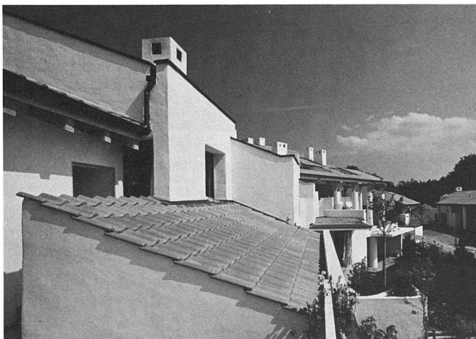
70, 71 Haus 5 (Architekt / architecte: Rolf Keller).
