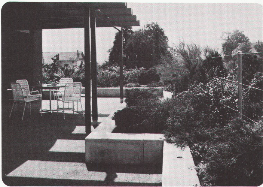
Objekt: Alters- und Krankenheim Seuzach ZH, ca. 600 m 2 Dachbegrünung, Schichthöhe 35 cm. Planung: Architekten Isler + Isler + Zirn, Winterthur. Ausführung und Gartengestaltung: A. Bachmann und Sohn, Winterthur.
