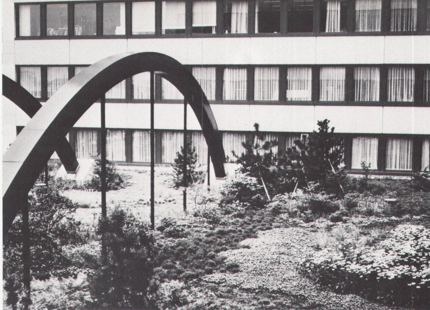
Objekt: Textil- und Modecenter Zürich-Opfikon. Ca. 1700 m 2 Dachbegrünung, Schichthöhe 35 cm. Generalunternehmer: Ortobau AG, Zürich. Architekt: von Tobel, Gurçan, H. Kehrer und Limburg, Zürich. Gartenarchitekt und Gartengestaltung: Fritz AG, Zürich.
