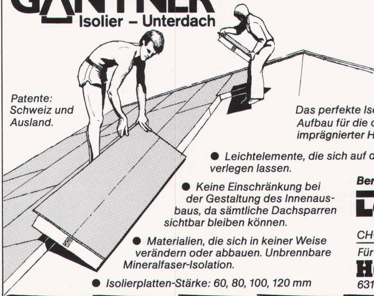
Das perfekte Isolier-System mit dem logischen Aufbau für die optimale Vollisololation. Mit überlappender, imprägnierter Hartfaserplatte.
