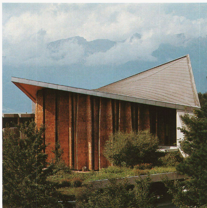
Fassadengestaltung einer Holzkonstruktion: Kapelle Bethanienheim, St. Niklausen. Qualität Nr. 1.
