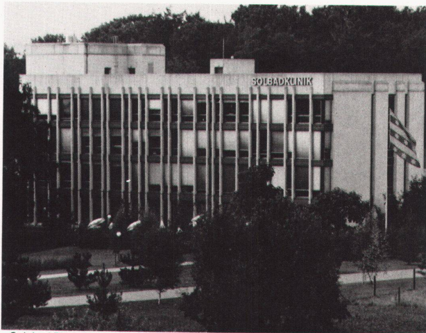
- Solebad Rheinfelden. Bodendämmung auf Erdreich.
