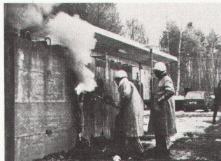
Die neuentwickelten Panzer-elemente der Bauer Kassenfabrik AG sind eingehenden Prüfungen unterworfen. Das Bild zeigt den Test mit der Sauerstoffflanze, einem der gefürchtetsten Angriffswerkzeuge.
