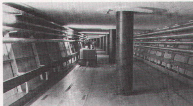
Transportkanal für Handgepäck im Flughafenbahnhof Kloten. VERMIPAN-Platten, 40 mm dick. Totale Wandlänge ca. 1200 Meter.
