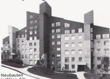
Neubauten in Wilen, SG. Überbauung mit Holz/IV-Fenstern.
