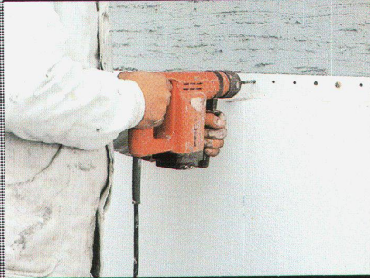
Montage der STO-Halteleisten.
