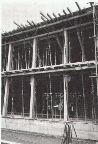
Bei einem Fabrikationsgebäude werden die Geschossdecken und das Dach durch standfesteste Säulen abgestützt.
