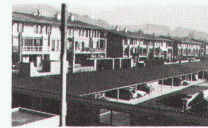
Wohnquartier Bleiche, Worb BE 01.07 Reihenhäuser Heft Nr. 4/1984 Architektengemeinschaft: F. Oswald, H.R. Abbühl/F. Hubacher
