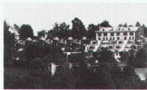
Eigentumswohnungen Rüti Adliswil, 1. Etappe 01.04/07 Reihenhäuser, Terrassenhäuser Heft Nr. 12/1982 Architekt: Peter Thomann, Adliswil
