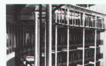
Amtshaus, Bern 07.01. Gerichtsgebäude Heft Nr. 10/1984 Architekten: Atelier 5, Bern
