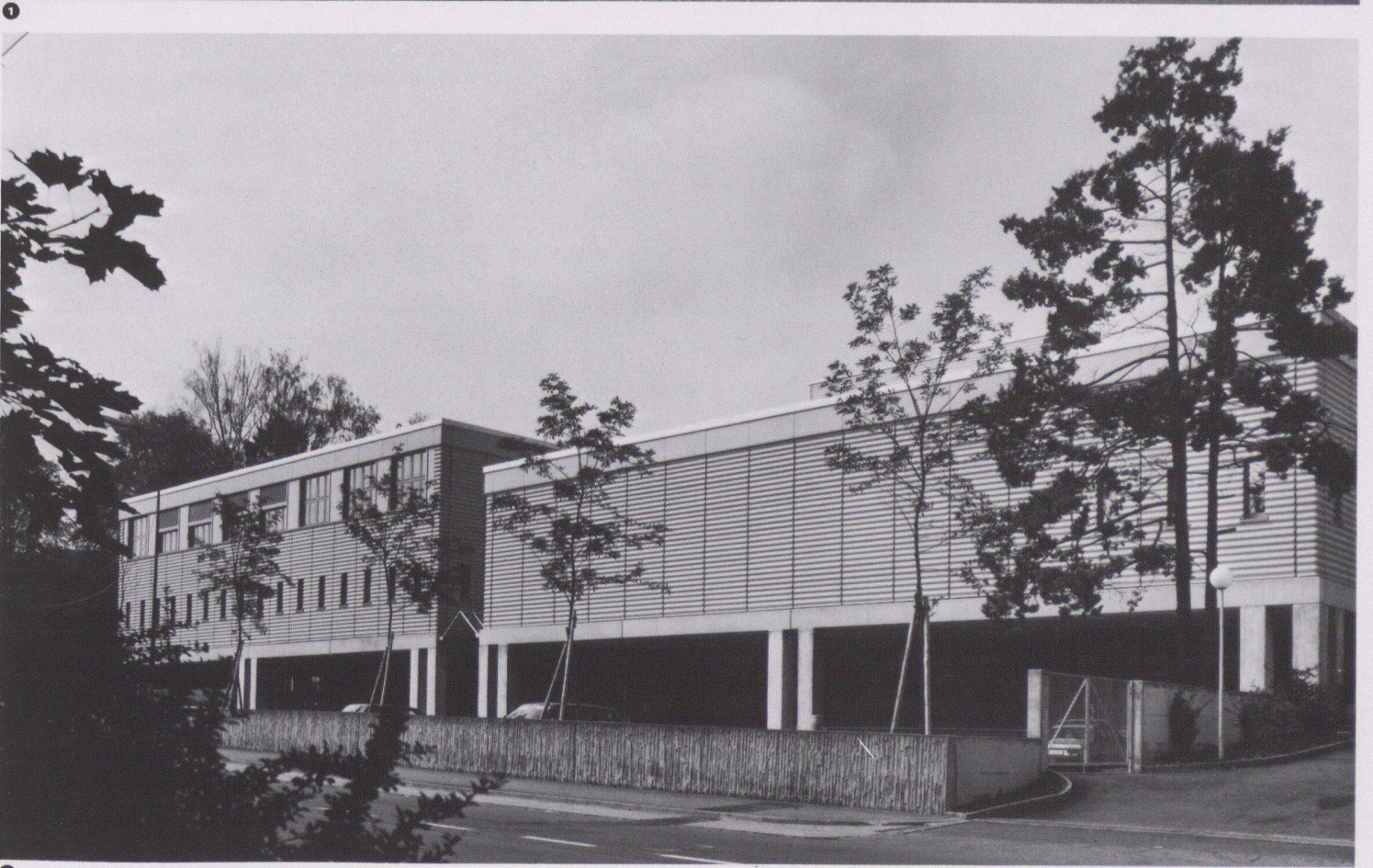
1 Ansicht von Süden, Zentrallager und Apotheke
