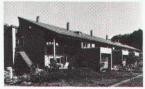
Wohnsiedlung am Tobelweg, Feldmeilen ZH 01.07 Reihenhäuser Heft Nr. 1/2, 1984 Architekt: R. Leu, Feldmeilen
