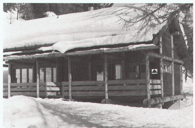
Haus «Pfahl», Bellwald
