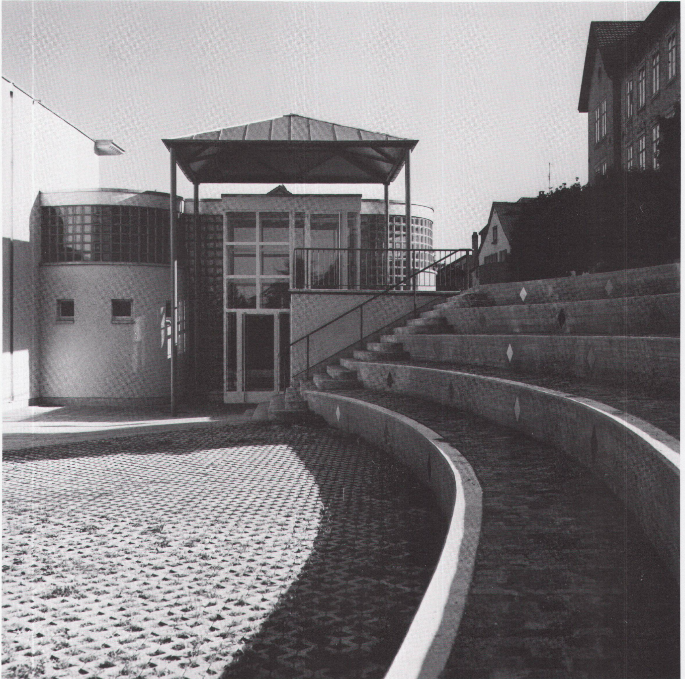
① Eingang zur Turnhalle ② Fassade gegen Norden
