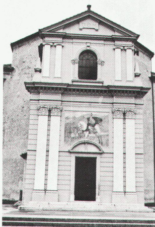
Chiesa parrocchiale in Bioggio. Progettista e Ditta esecutrice dei lavori: Luciano Pescia, Bioggio
