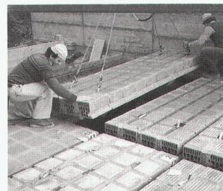
anzubringen. Die Decke bietet einen hervorragenden Wärmeschutz, da die Deckenziegel aufgrund ihrer geringen Rohdichte und der über den Querschnitt verteilten Lochkanäle einen hohen Wärmedurchlasswiderstand aufweisen. Sie ist für Räume mit hoher Luftfeuchtigkeit besonders geeignet, da das Ziegelmaterial Schwitzwasserbildung vermeidet. Bricomat AG, 8048 Zürich
