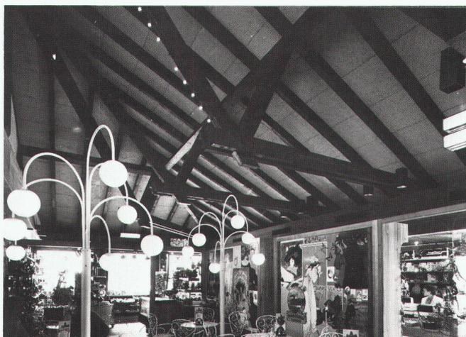
Autobahnrestaurant Mövenpick in Yverne-Aigle VD: 1200 m<sup>2</sup> Schichtex-Spezial 75/III, in Speziallängen, mit Längsfalz und Strukturanstrich, weiss gebrochen, auf Holzpfetten montiert.
