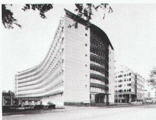
In der raumabschliessenden Ebene besteht die Fassade aus mehrschichtigen isolierten Brüstungspaneeelen mit dazwischengesetzten Fensterelementen vom Typ IS-70 der Ernst Schweizer AG.
