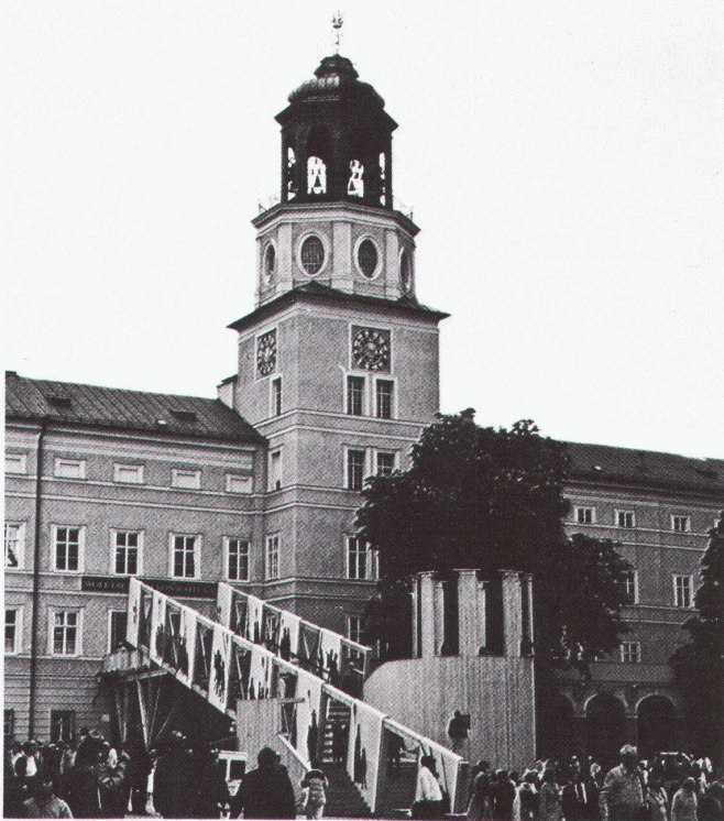
27 28 29 Gutachten Stiegenaufgang zum Eingang der Ausstellung «Wolf Dietrich von Raitenau», 1987, Architekt: Boris Podrecca / Rapport-expertise sur l'escalier d'accès à l'exposition / Expert opinion on the staircase leading to the entrance of the exhibition Treppenanlage aus Holzwerk (40×5 m), mit Sitzplätzen, Aussichtspavillon, Stufenrampe und Eingangsempore.
