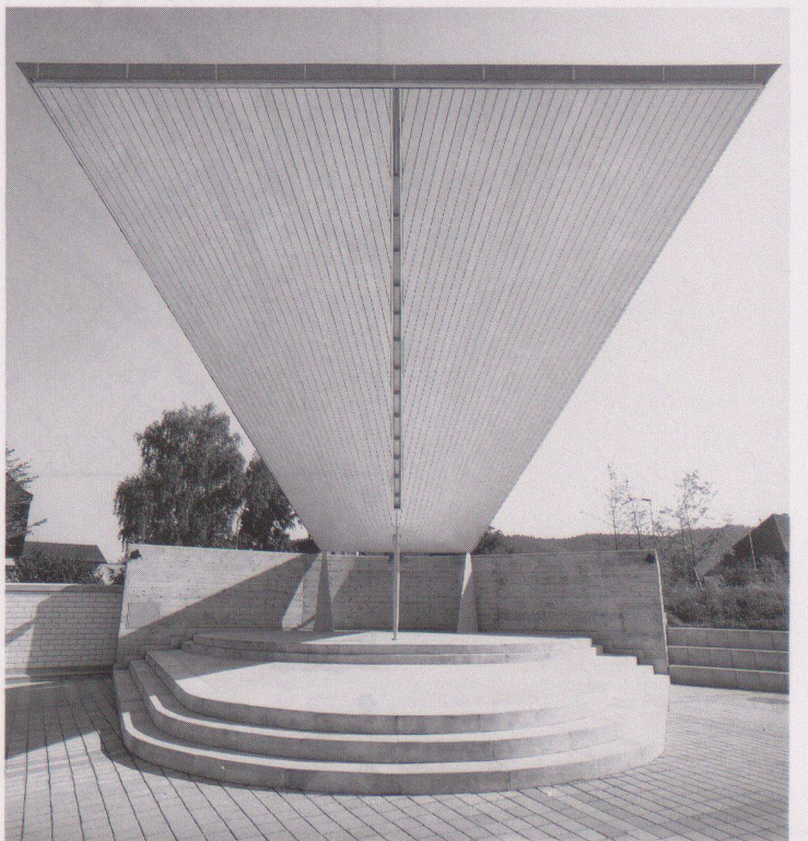
1 2 Saalbau, Ansicht von Norden und Westen 3 Musikpavillon
