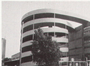
Rampe Parkhaus Migros Herdern
