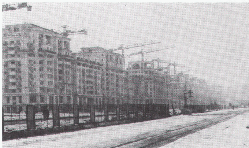
Massenwohnungsbau aus den achtziger Jahren
