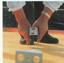
Durch das obere Loch des TAFIXE werden die Konterlatten ohne Vorbohren maschinell in die Sparren eingeschraubt. Das zweite Loch erlaubt die solide Verbindung von zwei Konterlatten.
