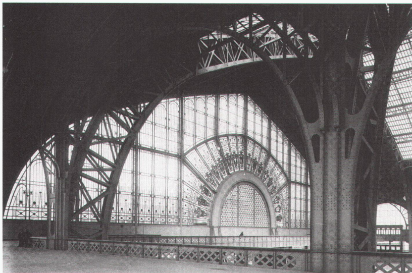
Galerie des Machines, Blick von der oberen Galerie auf die Innenseite der Hauptfassade L'intérieur de la façade principale vu de la galerie supérieure The Gallery of Machines, view from the upper gallery of interior side of the main façade Photo Chevojon
