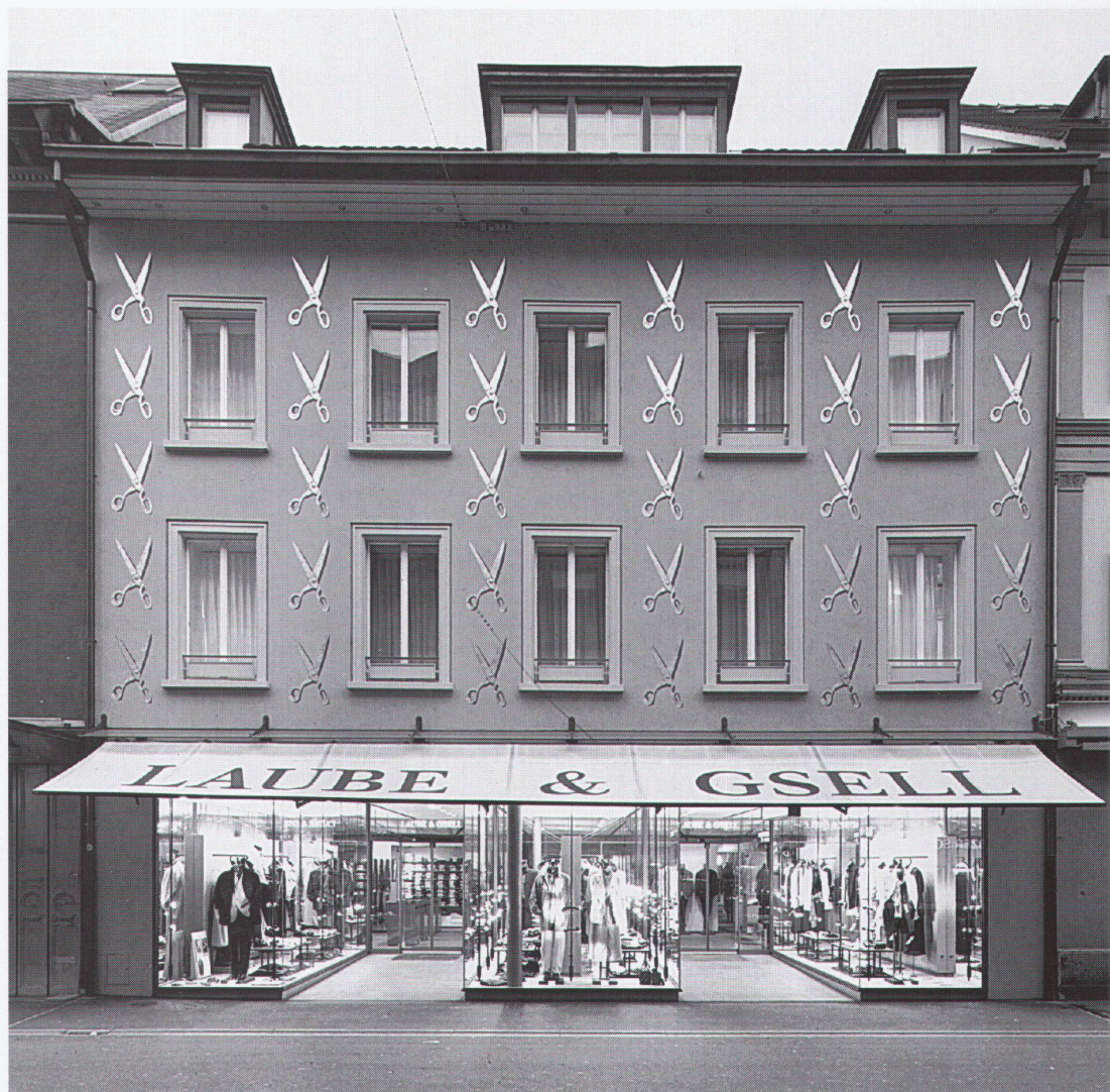
Ansicht Fassade Vue de la façade
